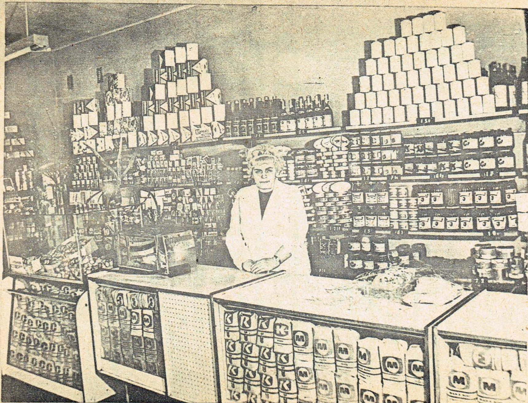
SKLEP NR. 35 PO MODERNIZACJI
