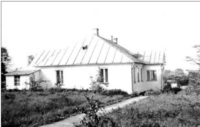
Fot. 2. Plebania – widok od strony południowej (fot. 1985 r.). Źródło: APIm, L. Domagała, Zarys dziejów parafii Imielno, t.2: Dokumentacja zdjęciowa, mps, Imielno 1986.
